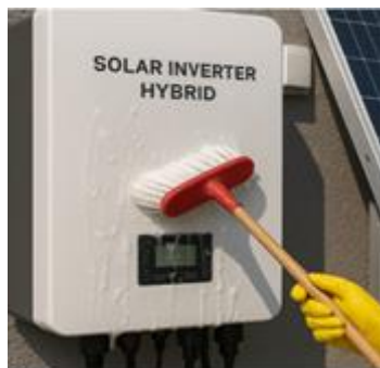
Fig.9.10. Entretien d'un onduleur hybride
