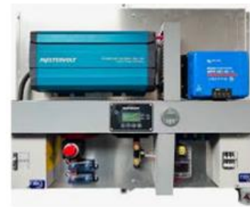
Fig.8.7. Pose onduleur classique et régulateur de charge
