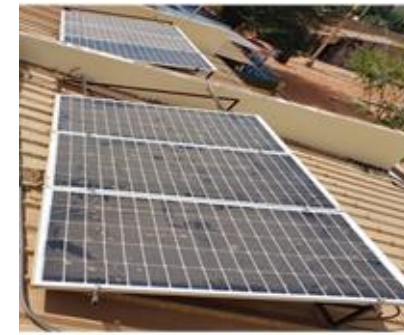
Fig.8.5. Pose panneaux au toit
