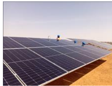
Fig.8.4. Pose panneaux au sol
