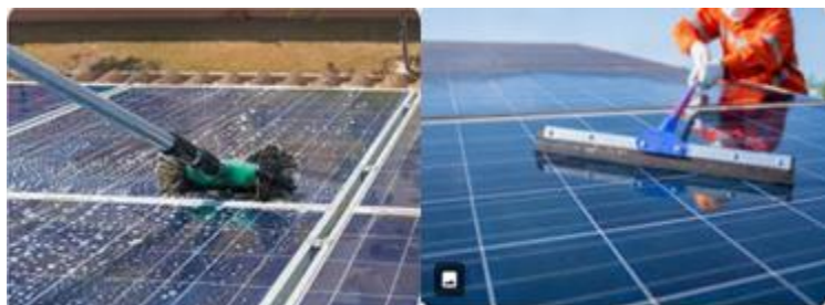
Fig. I 2.7. Entretien panneaux solaire pour pompage
