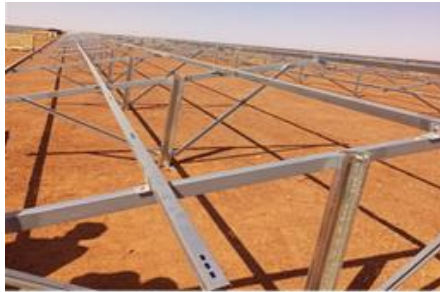
Fig.8.3. Support panneaux au sol
